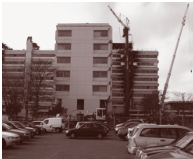
▲ De oostvleugel van het Smedinggebouw, ongeveer vijf dagen na de brand.
